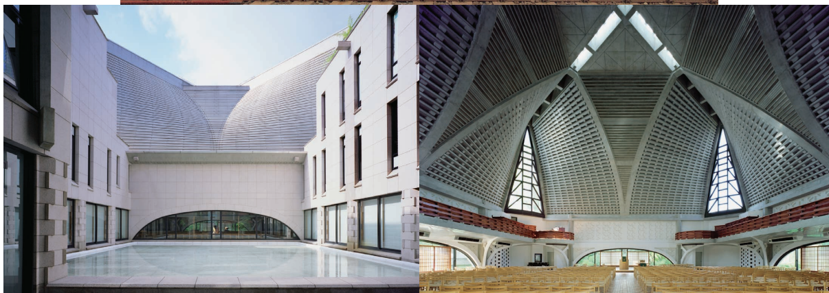
Photo. 1 淀橋教会 (東京都新宿区) Yodobashi-church (Shinjuku, Tokyo) 写真提供：淀橋教会・稲富建築設計事務所 Photo courtesy of Yodobashi-church & Inadomi office
