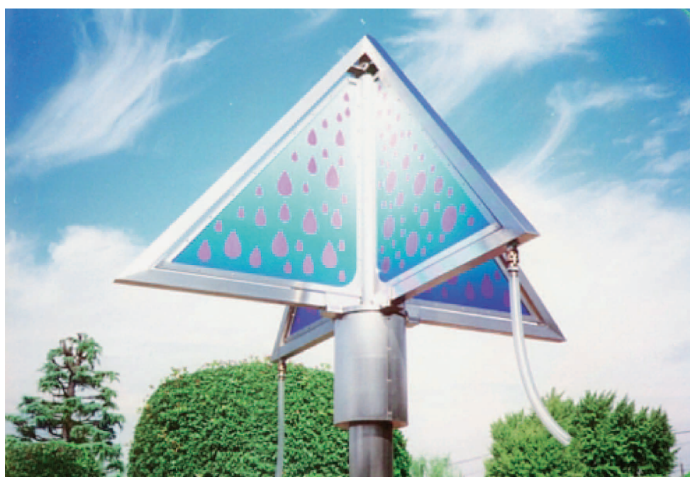
Photo. 3 健軍公園給水塔 (熊本県熊本市) Kengun Park Water Tower (Kumamoto, Kumamoto) 写真提供：(株)ホリエ Photo courtesy of Horie Corporation
