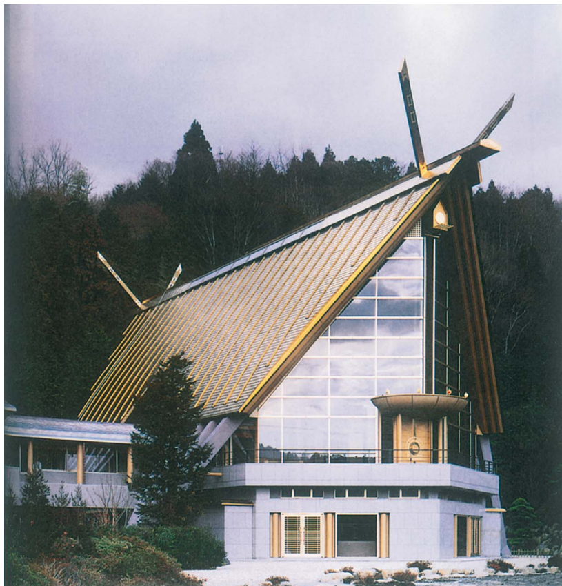
Photo. 1 嶽之下宮 (静岡県小山町) Takenoshitamiya (Oyama, Shizuoka) 写真提供：嶽之下宮 Photo, courtesy of Takenoshitamiya
