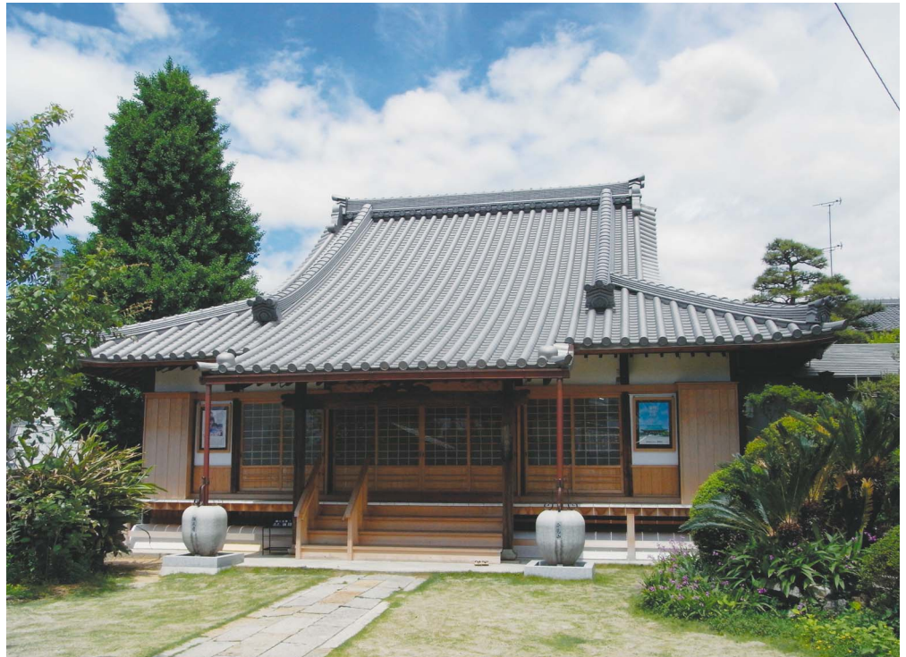
Photo. 4 願成寺 (愛知県豊橋市) Ganjoji (Toyohashi, Aichi) 写真提供: (株)カナメ (施工) Photo, courtesy of Caname Co., Ltd. (construction)
